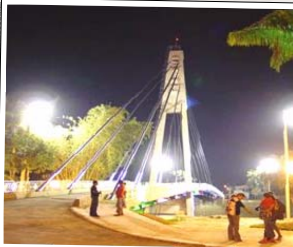
• Ponte binacional Brasil/Bolívia
