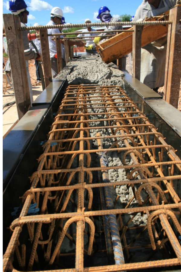
Concretagem de pré-moldado (viga e pilar), detalhe ferragens.
