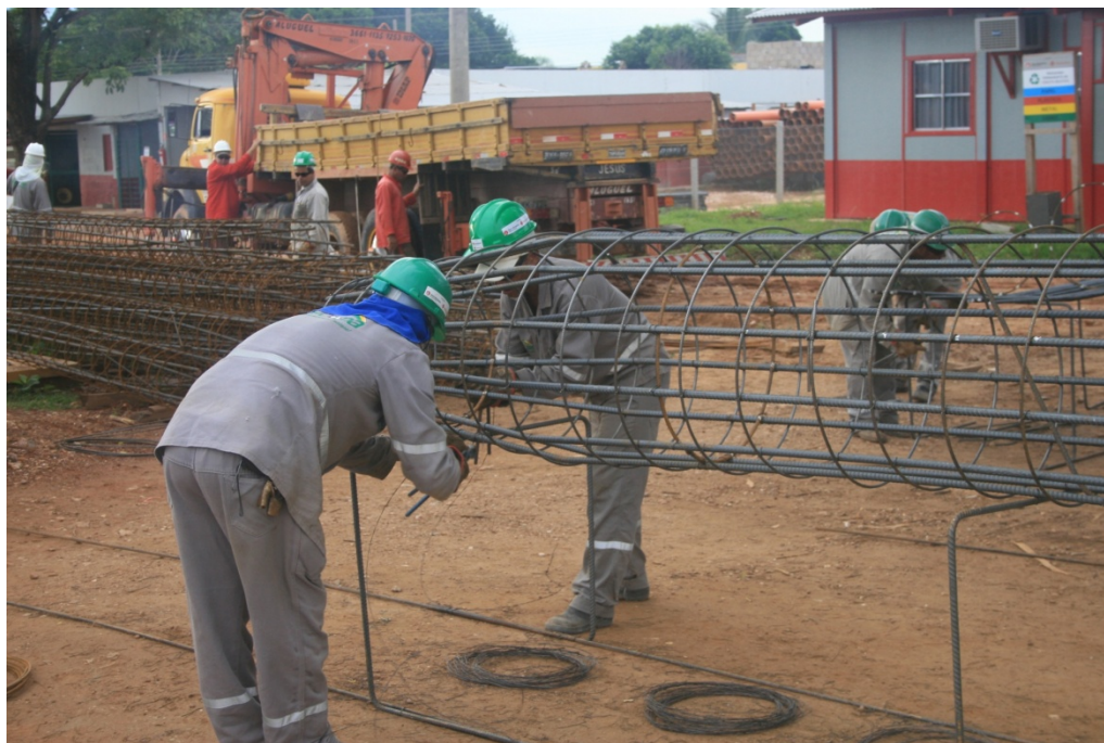
Armação e estoque de ferragens de estacas hélice contínua.
