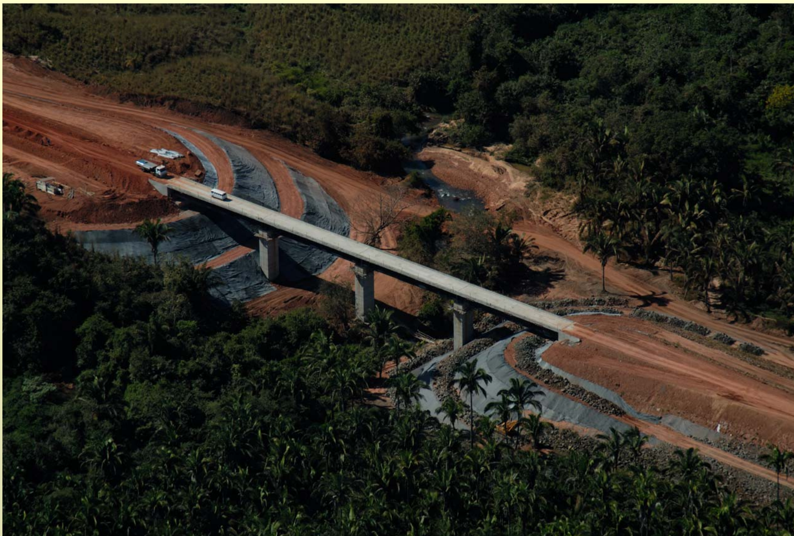
Ferrovía Norte-Sul – Ponte do Jatobá (Km 298 + 630)
