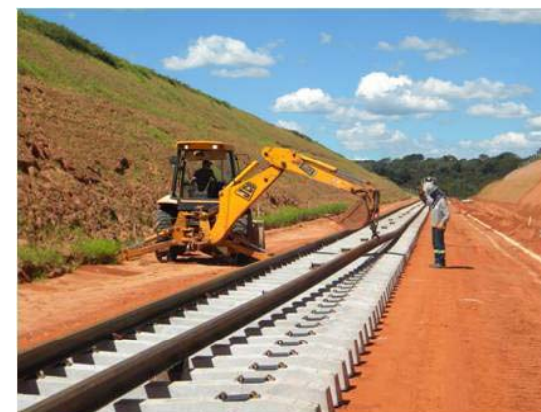
Assentamento de barras na linha principal
