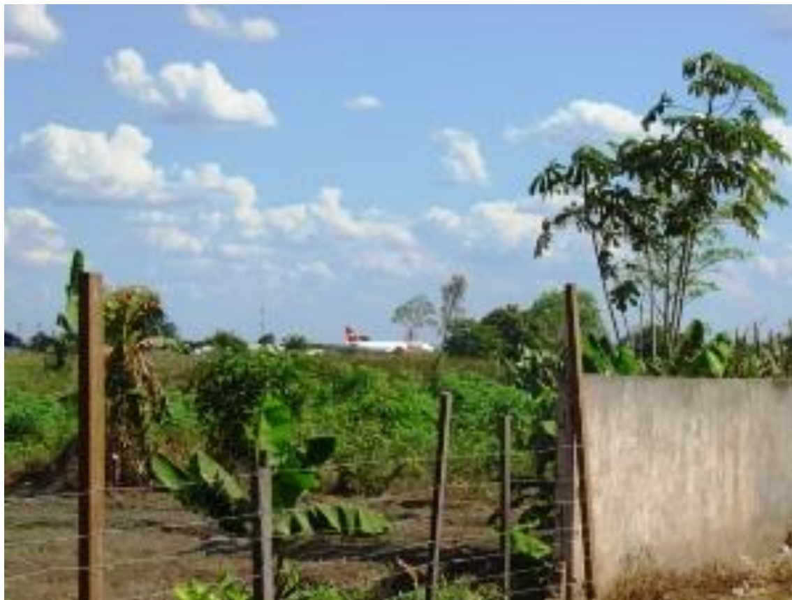
Cerca patrimonial rompida
