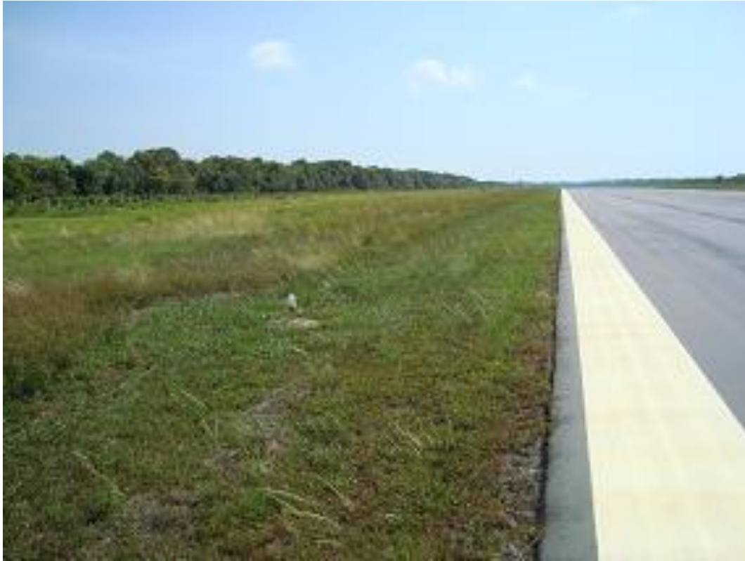
Faixa de Pista de Pouso e Decolagem
