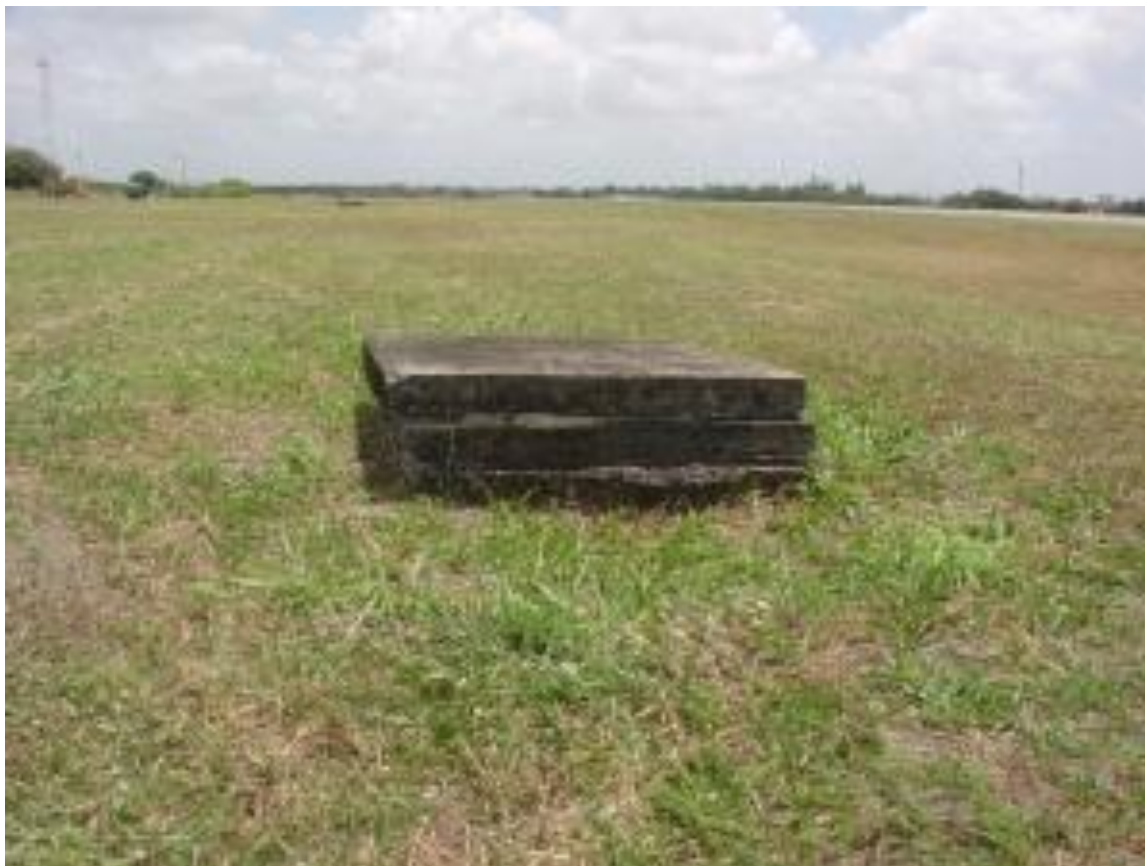
Caixa de passagem com batente acima da cota nula dentro da faixa de pista.
