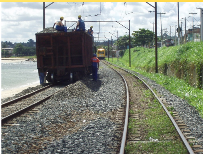
Substituição de lastro na via
