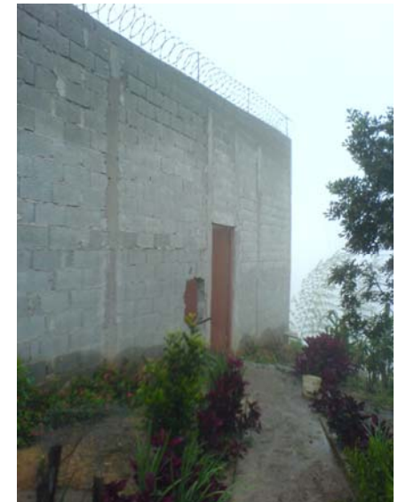
ACESSO AOS EQUIPAMENTOS
