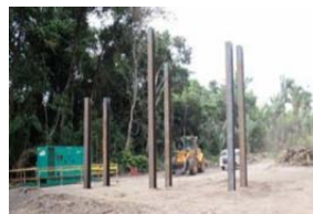
PONTE SOBRE O RIO IGARAPÉ DO PERU
