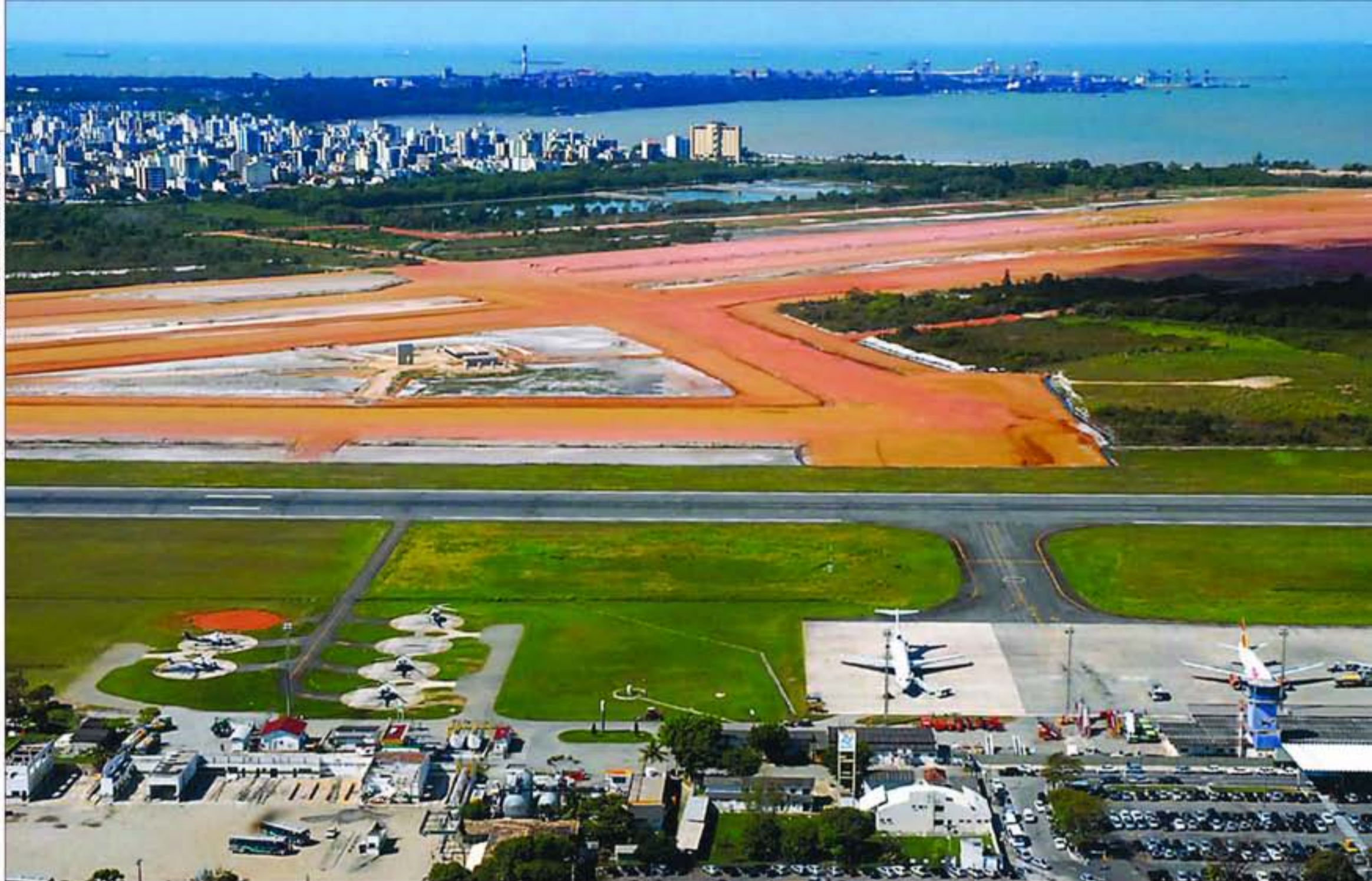
Aeroporto de Vitória: reforma foi interrompida em 2005 por determinação do TCU, que encontrou indícios de superfaturamento
